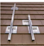
支持瓦工法 対応屋根材④⑤
