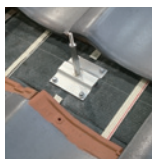
アンカー工法 対応屋根材④⑤
